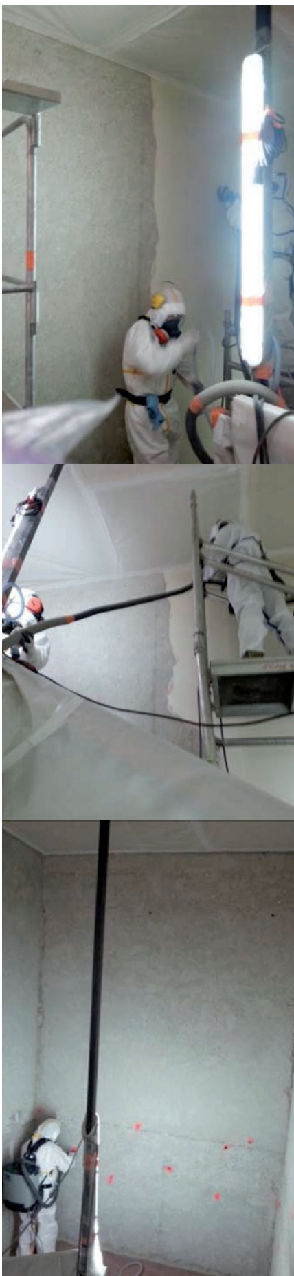
Désamiantage sous adduction d'air externe des enduits muraux amiantés de la cage d'escalier FAM
