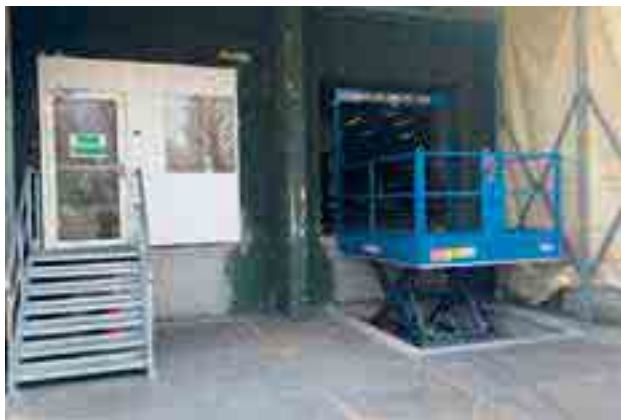
Accès chauffeurs et plateforme livraison coursiers
