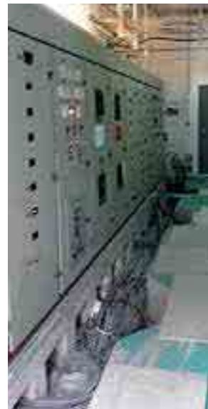
Démantèlement complet de l'ancien TGBT, une alimentation électrique de secours maintient le site en fonctionnement
