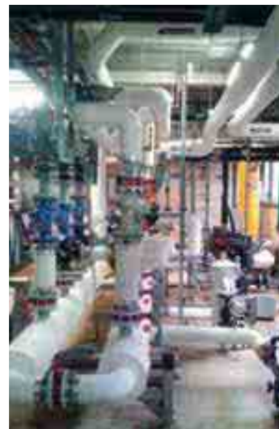
Nouveau réseau secondaire
