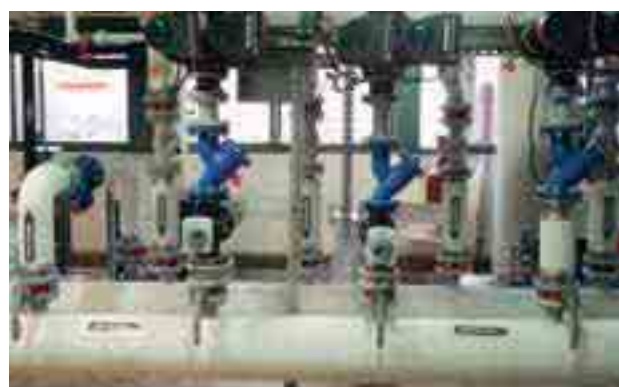
Nouveau réseau secondaire
