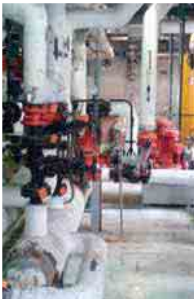
Ancien réseau secondaire
