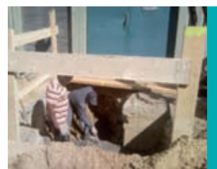
Chantier de remplacement du bac à graisse
