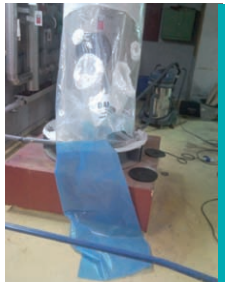
Sac à manches pour le désamiantage des joints de trous d'hommes sur cheminées en chaufferie de l'AGEPS
