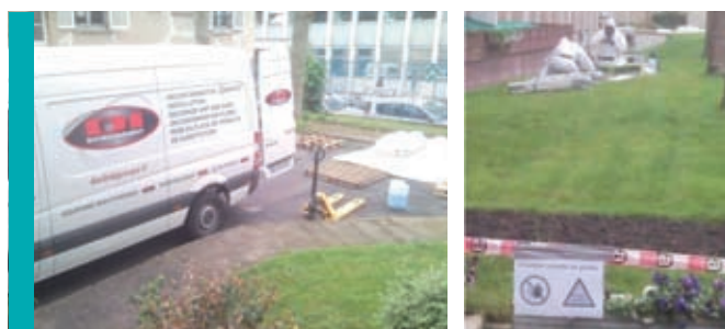
Chantier de retrait des jardinières (emballage sous double enveloppe polyane)
